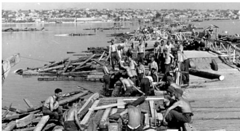
Немецкие саперы ремонтируют Варваровский мост через Южный Буг в оккупированном Николаеве. Фото от 23 августа 1941 года — через неделю после начала оккупации города
