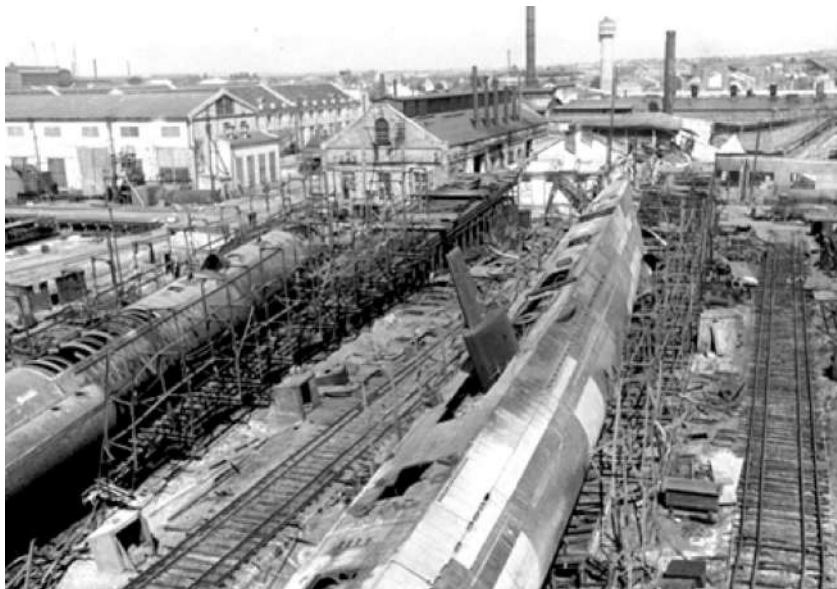
Недостроенные советские подводные лодки С-36 и С-37 на судостроительном заводе им. Марти в Николаеве.
